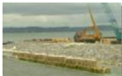
浅海域の汚濁防止用の土嚢
