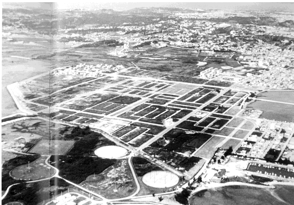
区画整理工事の様子
