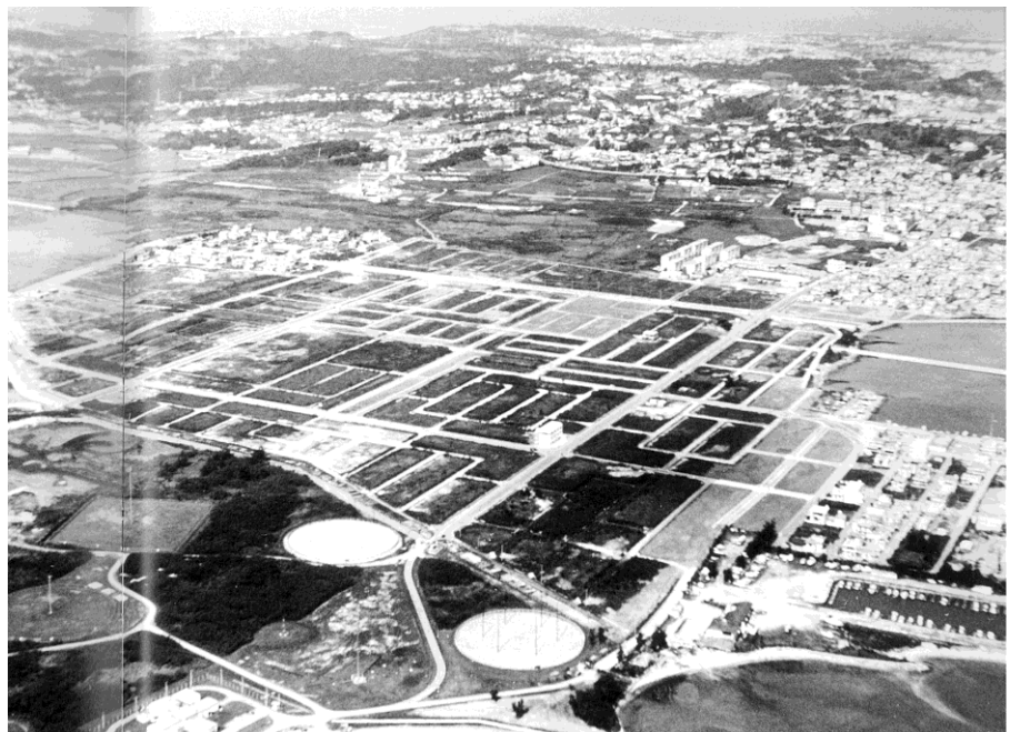
区画整理工事の様子
