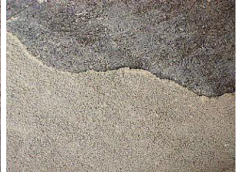
木毛セメント板の表の吹付け材
