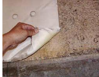
グラスウール貼りの裏の吹付け材
