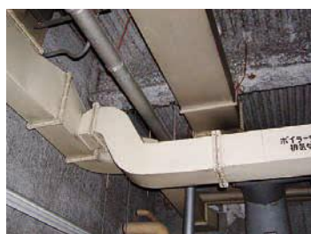
機械室の吹付け材
