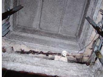
エレベーターシャフト内の吹付け材
