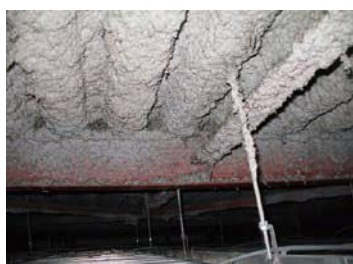
天井裏の吹付け材
