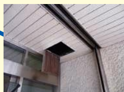
玄関横シャッター周り
