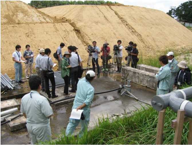
St. ① 調査地点状況 (平成 25 年 6 月 25 日)
