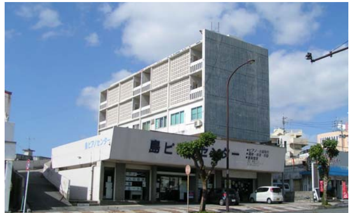
花ブロックを活用した店舗
