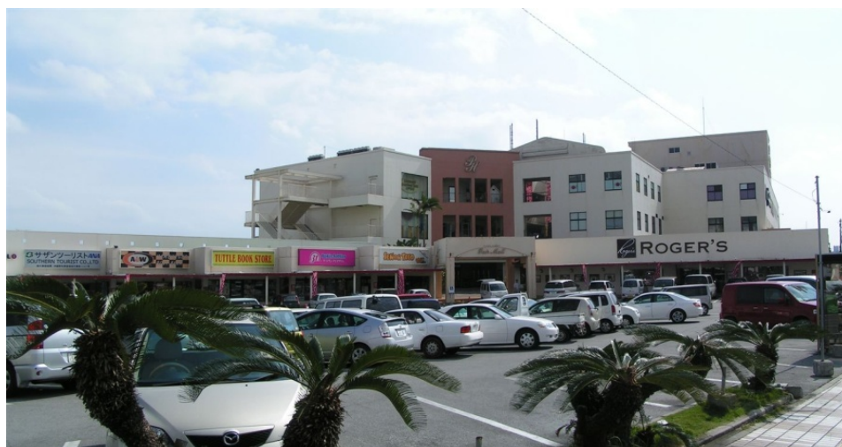
プラザハウス
