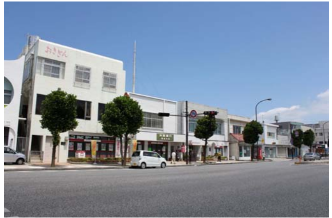
国道 330 号沿線のコンクリート建築群
