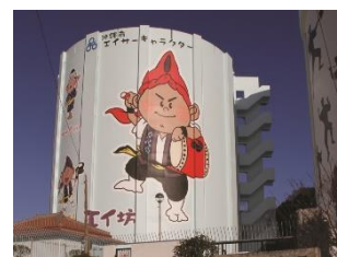
八重島第2配水池
