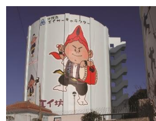
八重島第2配水池
