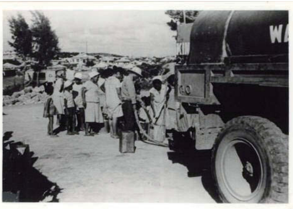
照屋地域への給水の様子(1963年)
