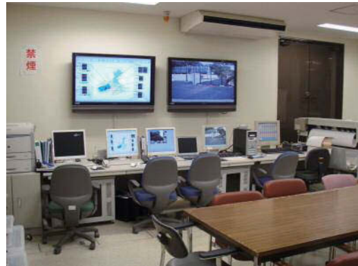
新庁舎外観と計装監視室
