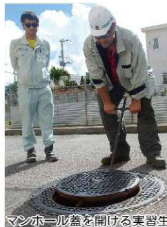
マンホール蓋を開ける実習生
