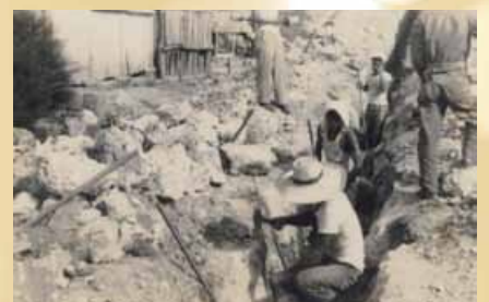
当時の給水工事風景 (掘削もツルハシやスコップ等を用いての作業であった)
