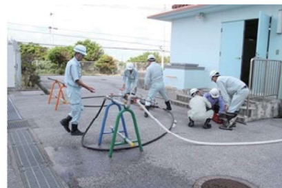
沖縄市防災訓練における応急給水栓設置訓練
