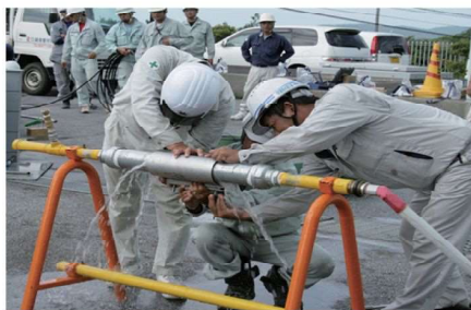
沖縄市管工事協同組合との応急復旧訓練
