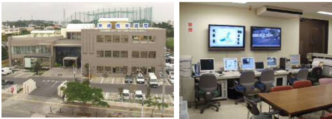
新庁舎外観と計装監視室
