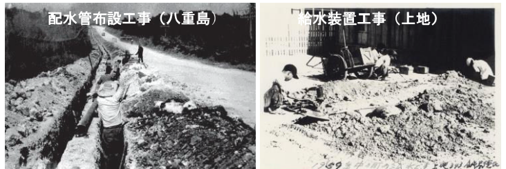
当時の水道工事の様子(1959年)
