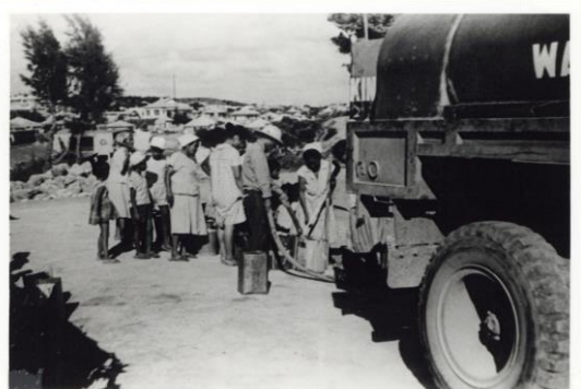
照屋地域への給水の様子(1963年)
