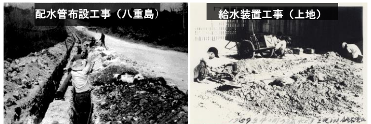
当時の水道工事の様子(1959年)
