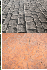
↑スタンプコンクリート舗装 草原のパビリオン内 鍾乳石洞窟のイメージ
