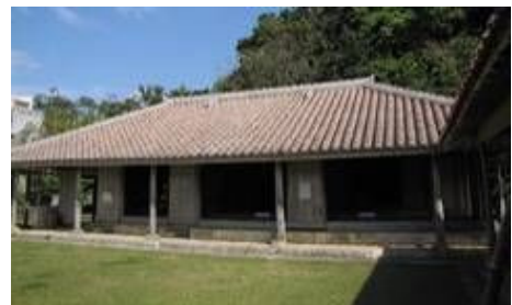
写真：ふるさと園に移築、復元された建物
