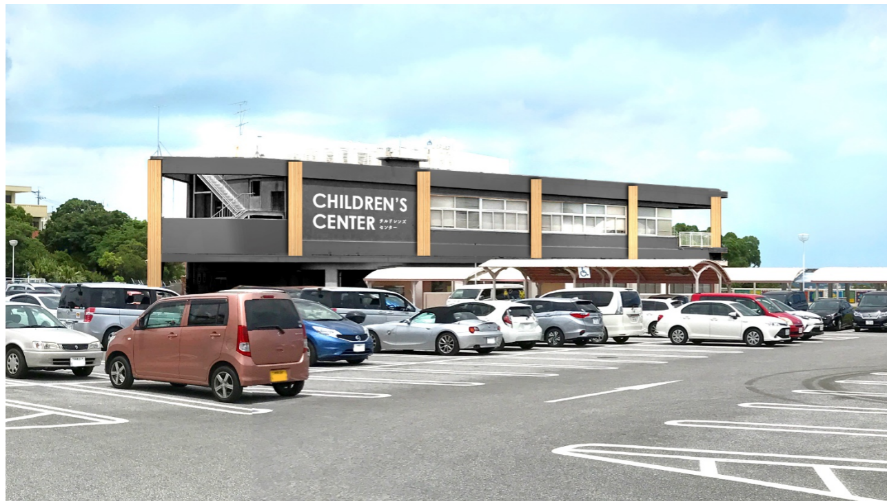
※チルドレンズセンターの外壁の改修例
