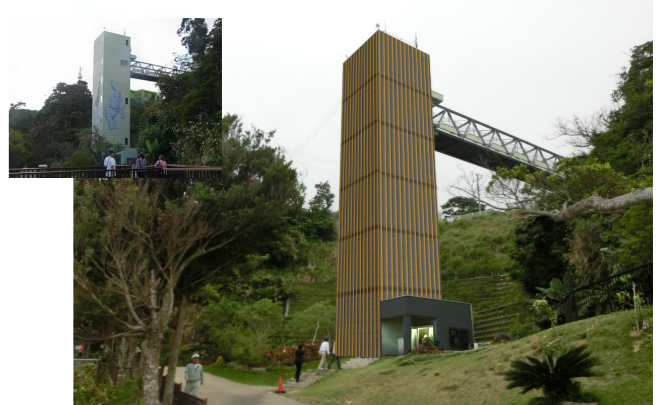
※エレベーターの改修例
