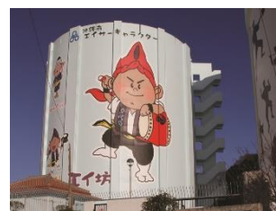
八重島第2配水池
