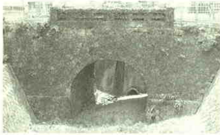
カフンジャー橋
