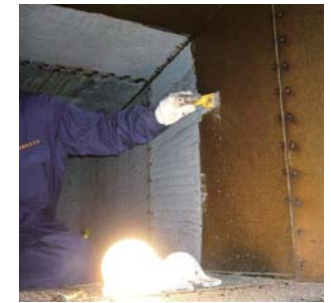
ダクト内の洗浄の様子 [出典:(社)日本空調システムクリーニング協会]
